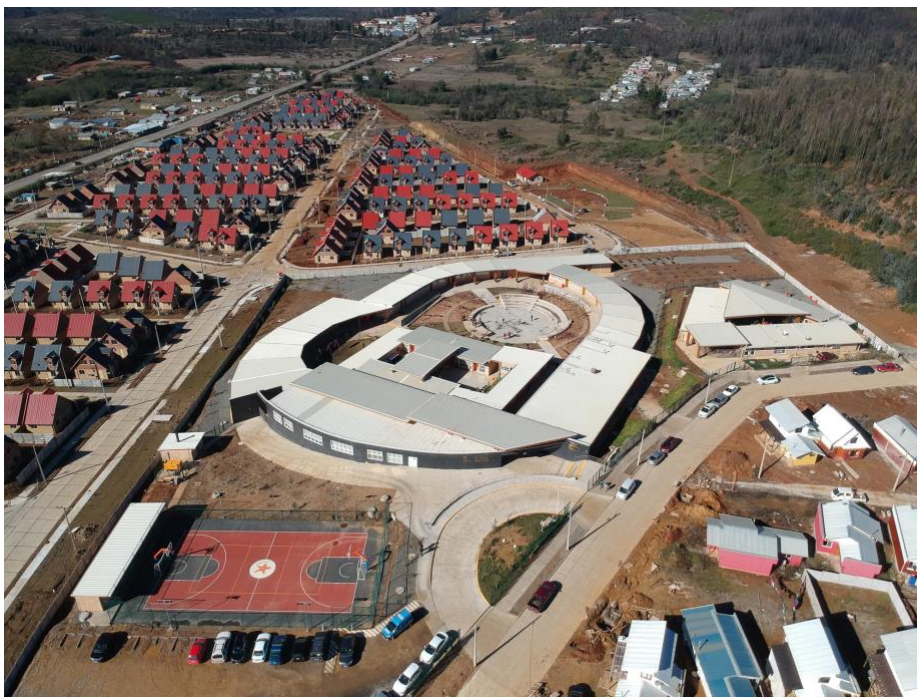
Imagen 18: Toma Aérea Villa Nueva Santa Olga aún en construcción (TV Maule, s.f.)
