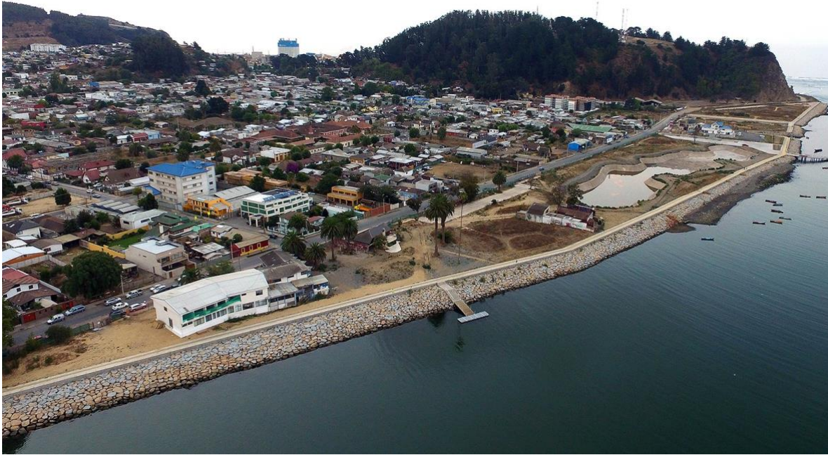
Imagen 23: Parte de la costanera del Río Maule en la obra ya culminada de parte del Parque de Mitigación Fluvial
